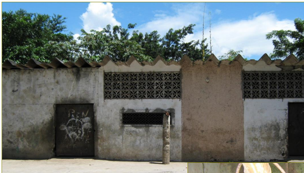
Vista externa de rastro municipal
