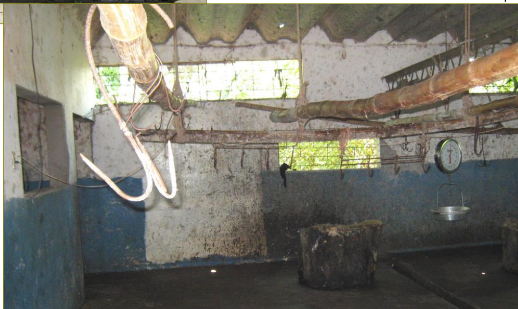
Vista interna de rastro municipal
