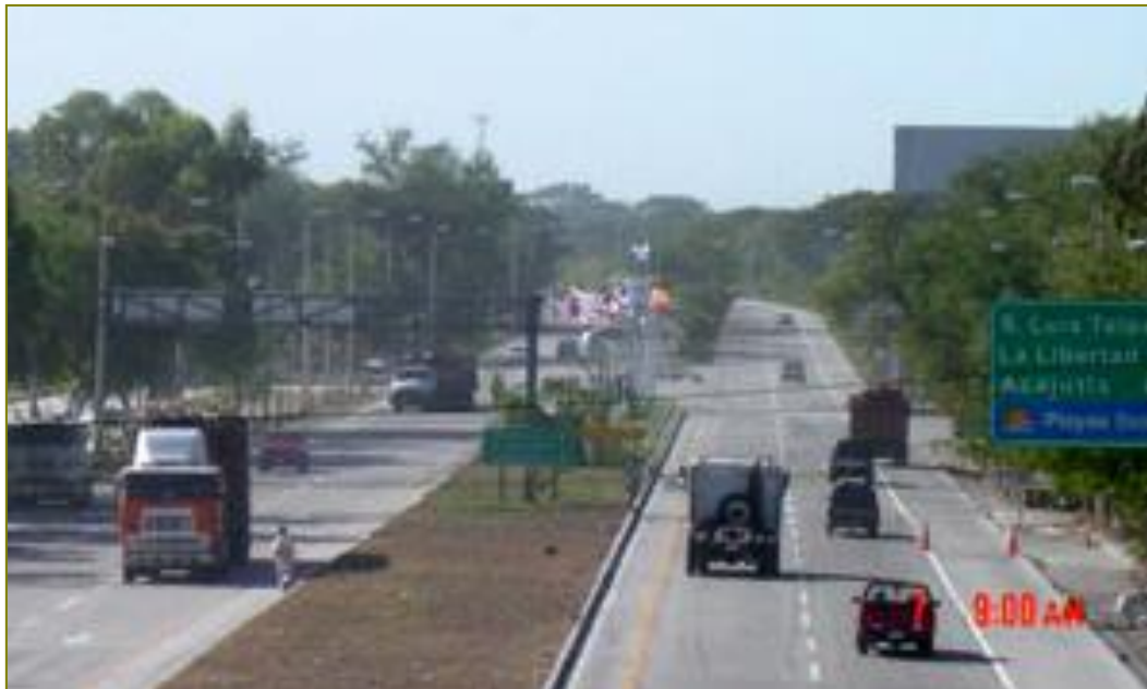
Tramo de autopista San Salvador-Aeropuerto
